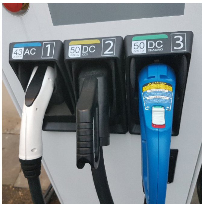
Zdjęcie 8. Stacja z trzema punktami ładowania
